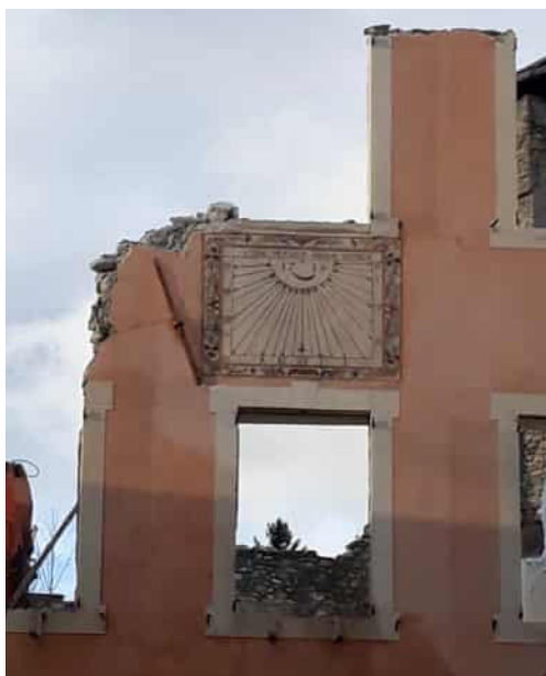
FIGURE 10 – La fin d'un cadran solaire à Guillestre (05).
