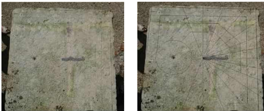
(a) Face supérieure très dégradé du cadran
